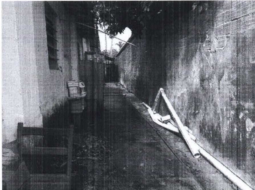
Vista externa área lateral da edificação.
