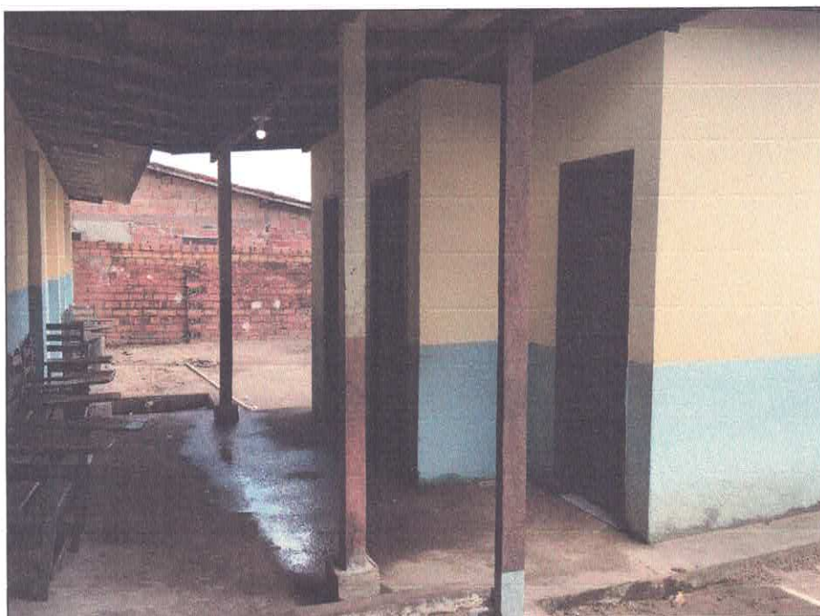
Vista externa área de banheiros.
