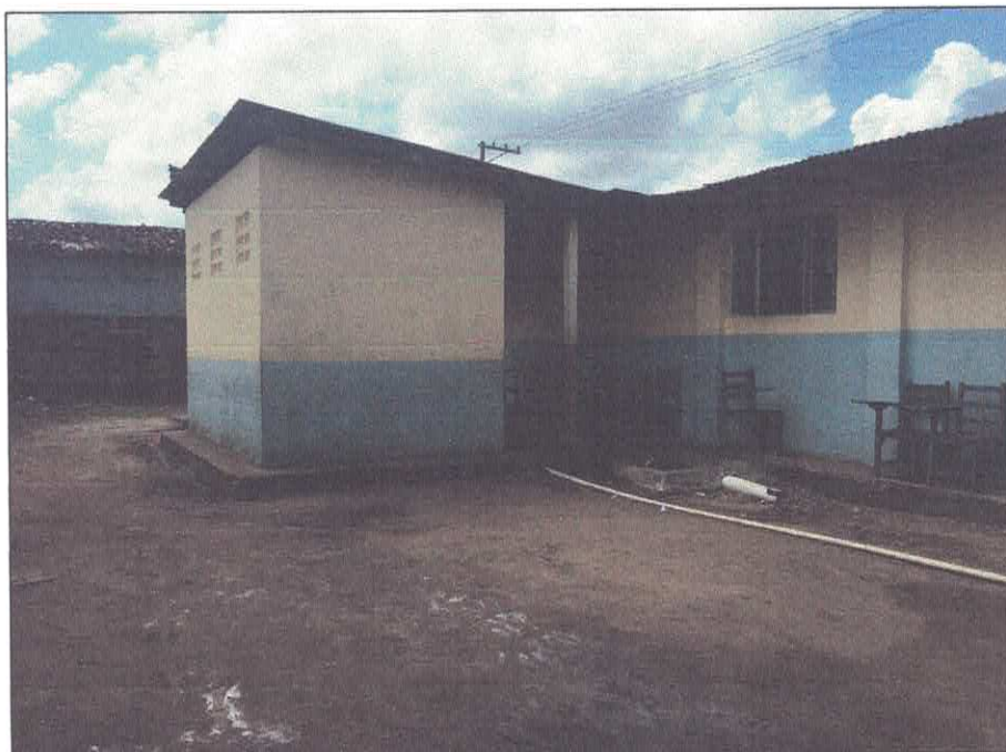
Vista longitudinal fachada posterior (fundos).
