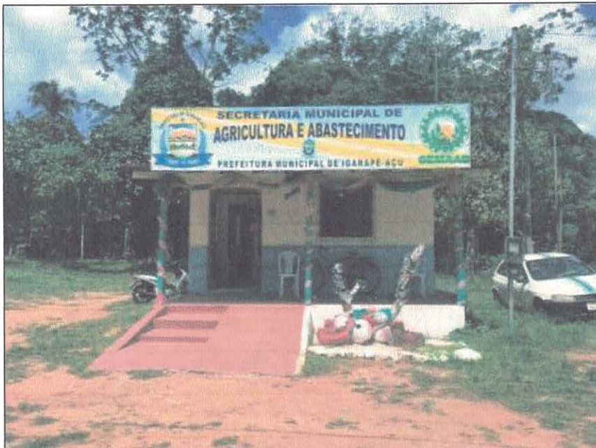
Vista frontal da edificação.
