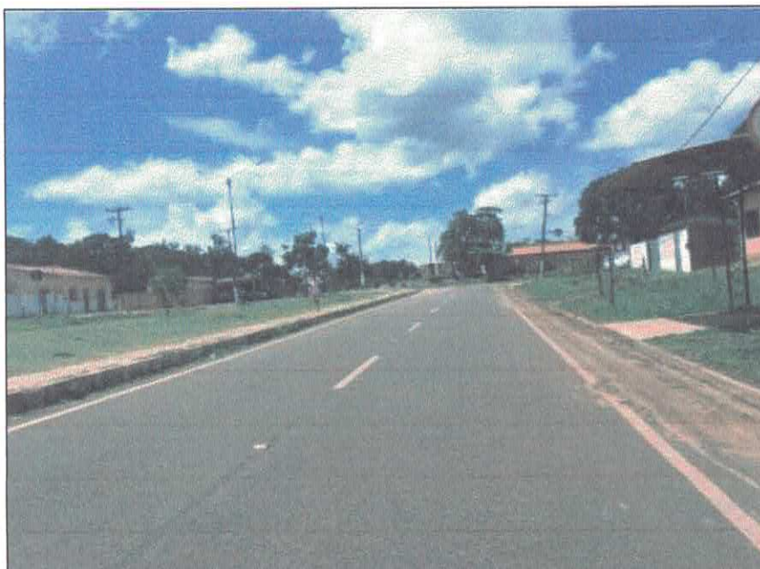
Vista longitudinal da Avenida Barão do Rio Branco (PA-320), sentido PA-320 Município de São Francisco.
