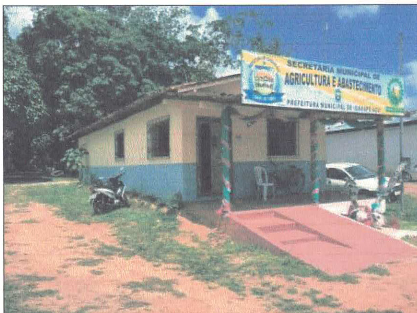
Vista lateral esquerda da edificação.
