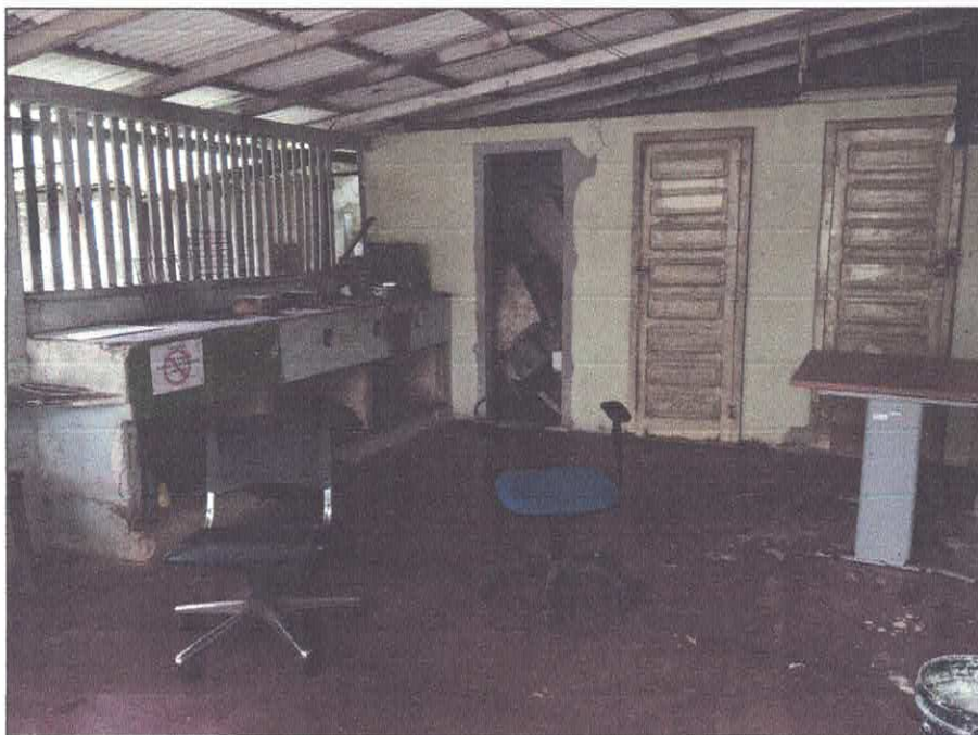
Vista interna depósito e área externa.
