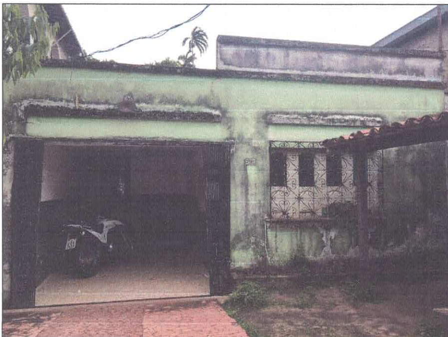
Vista frontal interna da fachada da edificação.
