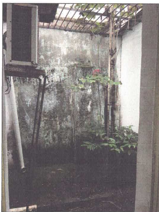
Vista interna jardim de inverno.
