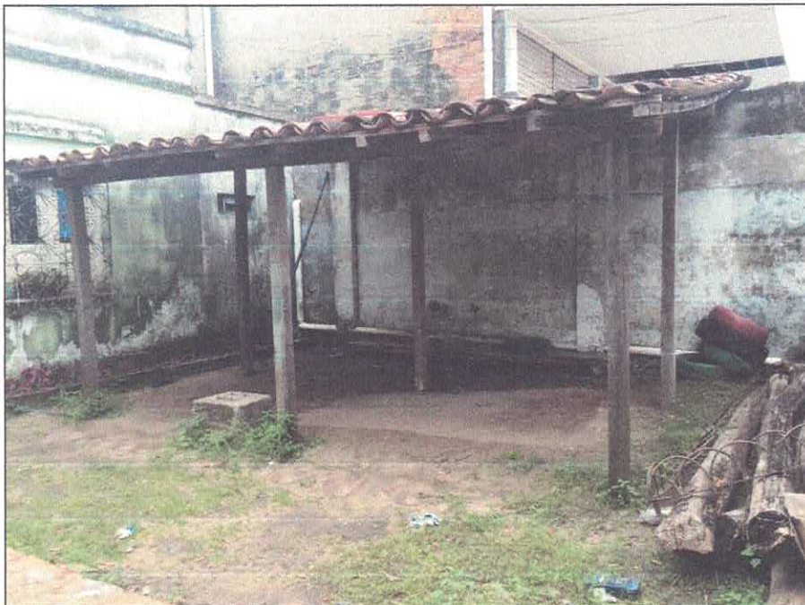
Área de estacionamento dos veículos da secretaria de Meio Ambiente - SEMMA.
