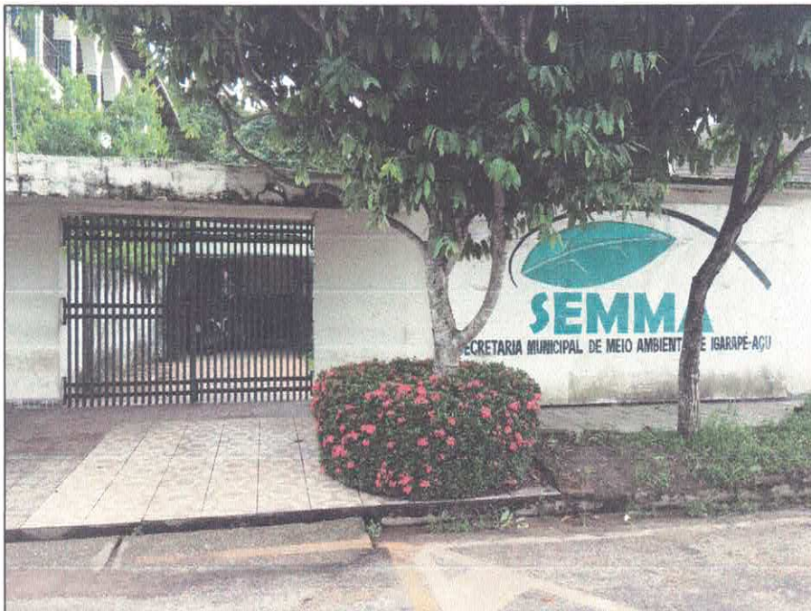
Vista frontal da edificação Avenida Barão do Rio Branco.
