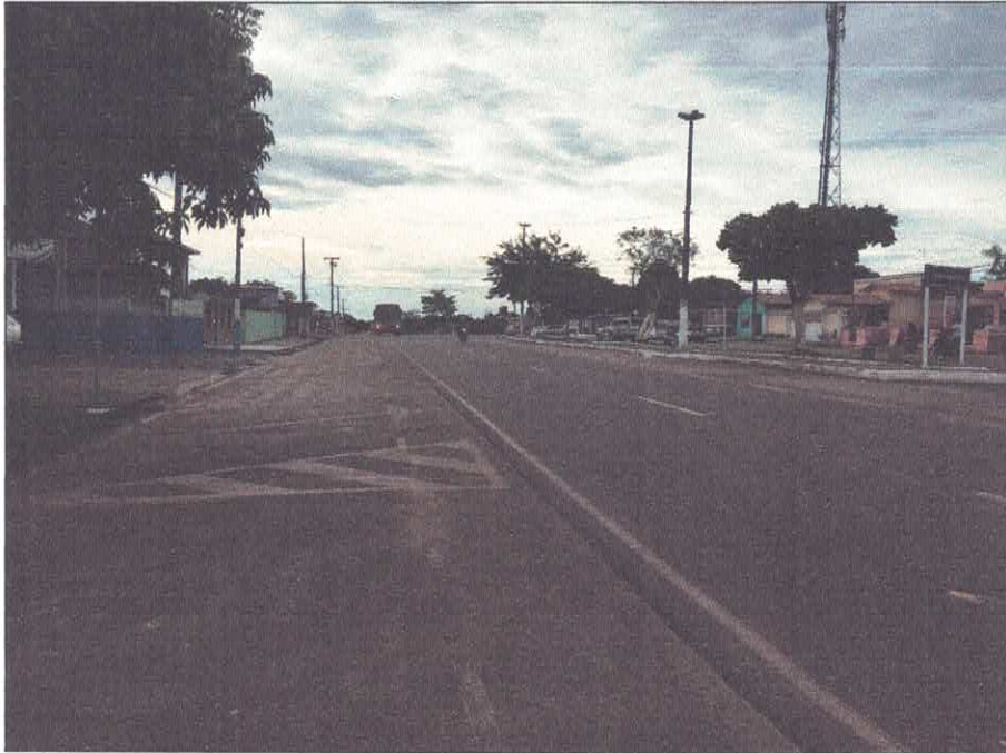
Vista longitudinal Avenida Barão do Rio Branco (PA-320), sentido município de São Francisco.
