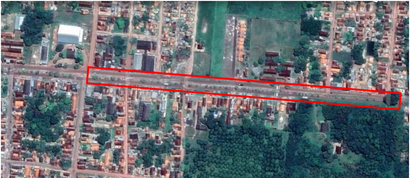
Vista longitudinal da área de revitalização do canteiro central
