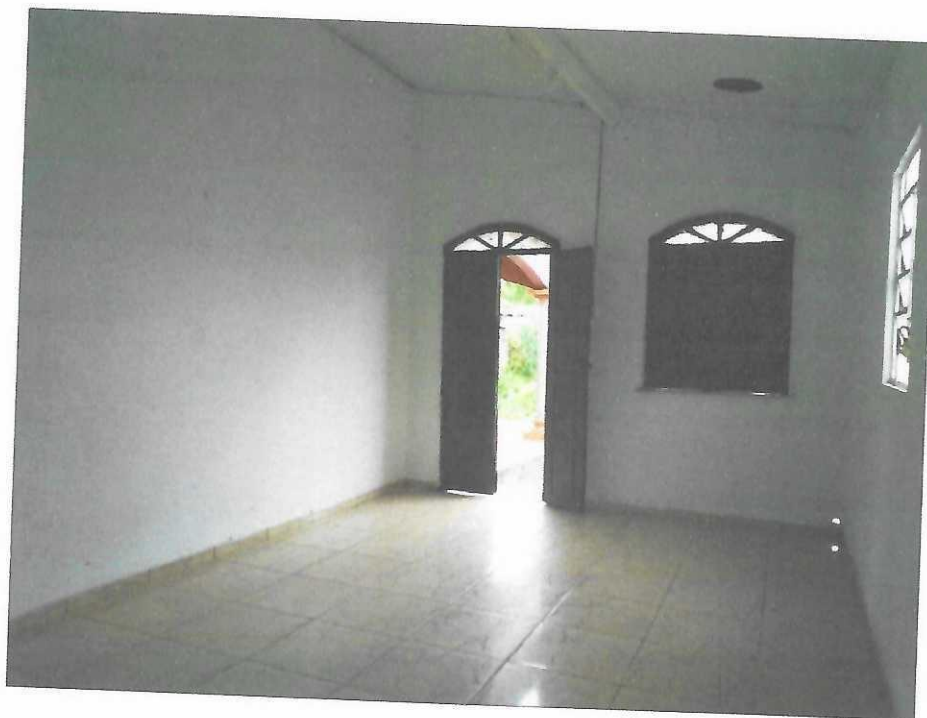
Vista interna Sala 01 – Casa de Apoio.
