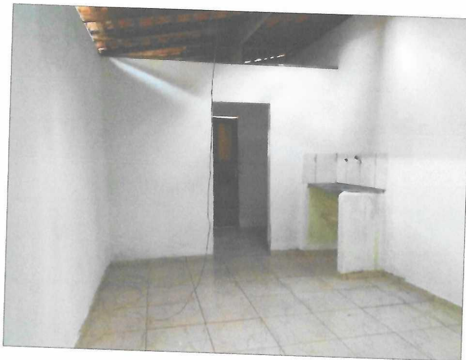
Vista interna Sala 04 – Casa de Apoio.
