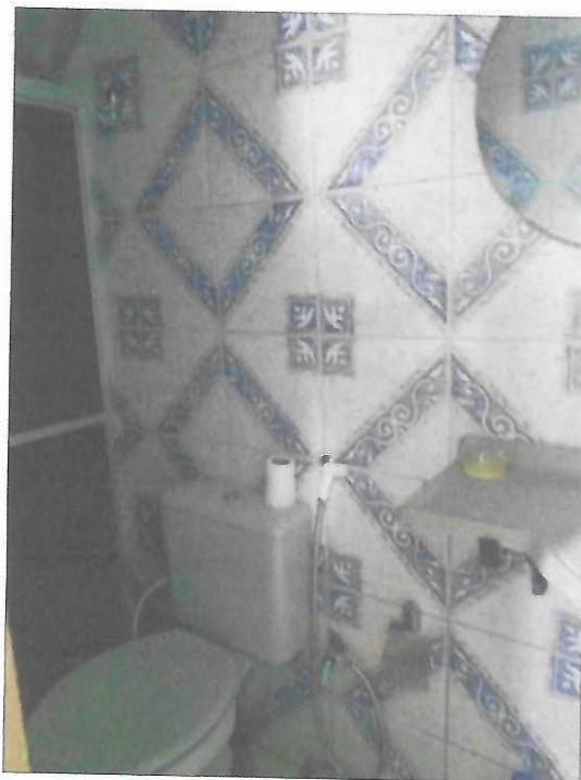
Vista interna banheiro Sala 03
