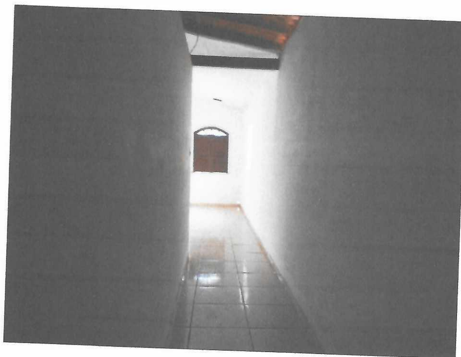
Vista interna Circulação – Casa de Apoio.
