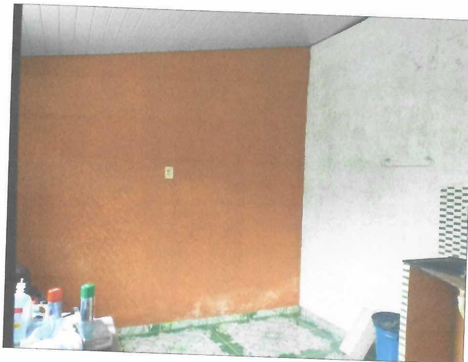
Vista interna Sala 01 – Bloco de Apoio.
