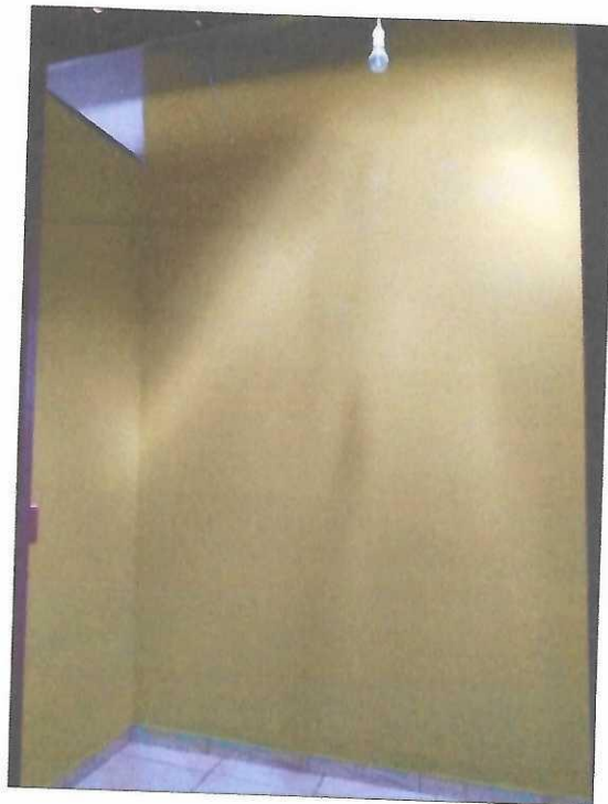
Vista interna Sala 03 – Casa de Apoio.
