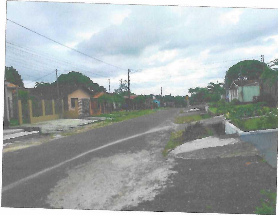
Vista longitudinal Avenida Marechal Deodoro, sentido Travessa 16 de Novembro.
