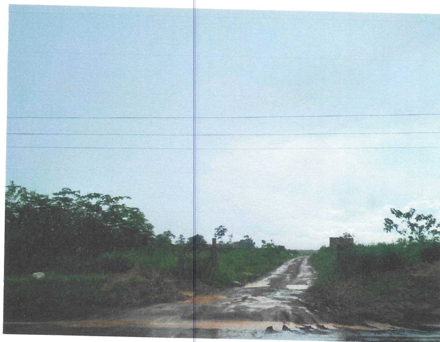
Vista longitudinal entrada do depósito sanitário.
