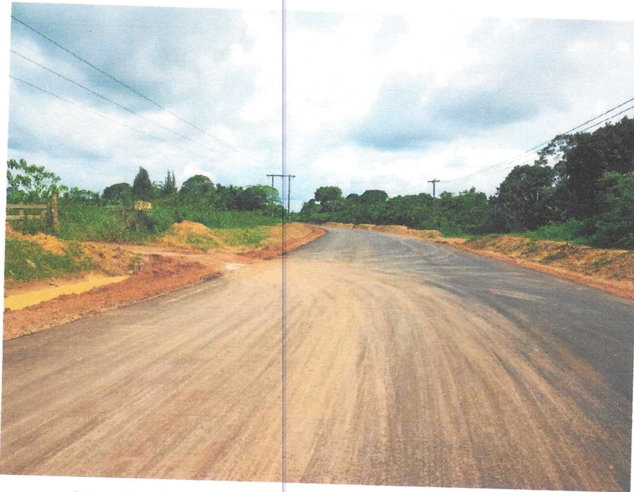
Vista longitudinal de acesso PA-424, sentido Vila do Curi.
